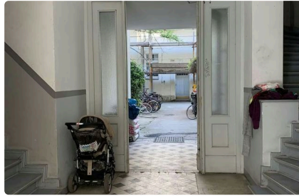
вид з під'їзду у внутрішній двір
